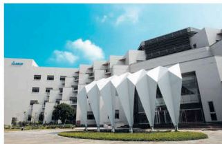
Завод в г. Тайнань
