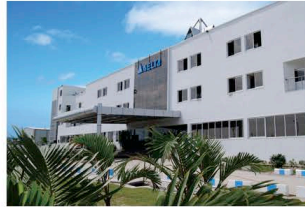
Завод в г. Рудрапур
